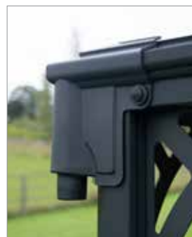
Vgrajen žleb in glave žlebov
